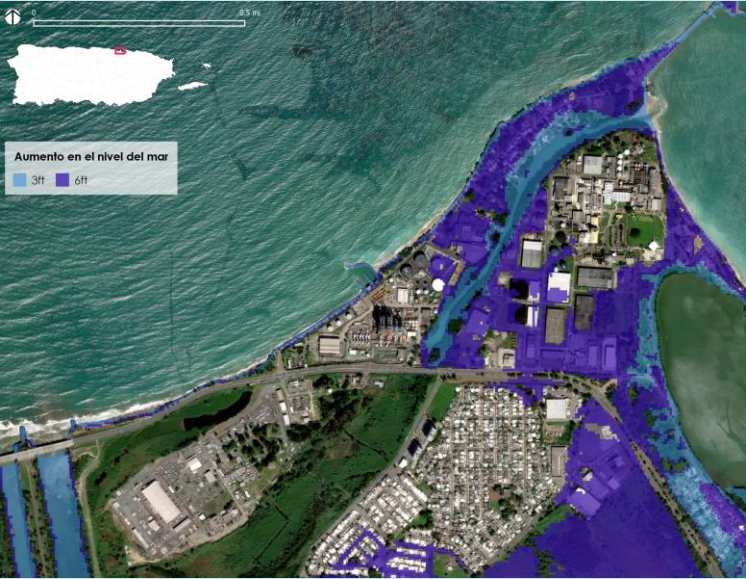
Palo Seco Power Plant Municipio: Cataño 3ft Sea Level Rise
